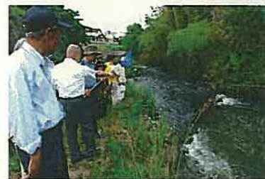
家下川合流点段差改善箇所の確認
