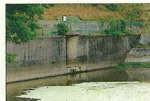
③承水溝一長池の段差 (承水溝側)
