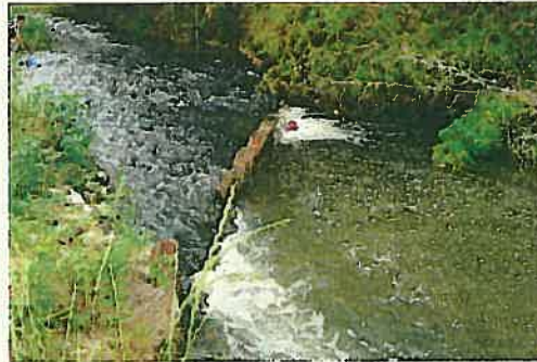
④矢作川本川合流部の段差改善カ所
