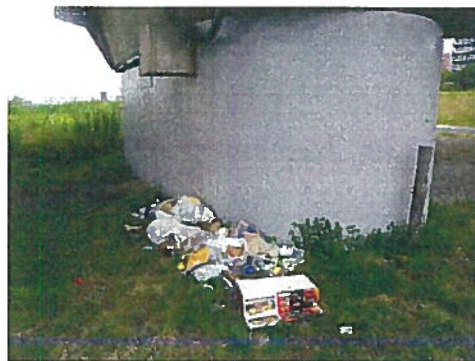
河川敷への不法投棄 ポイ捨て等による川への流出
