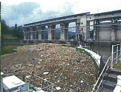
ダム施設等への機能障害
