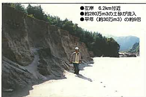
H12恵南豪雨時に矢作ダム貯水池に堆積した土砂
