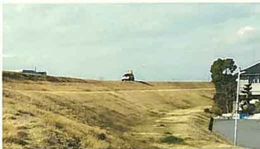
パトロール車による日常の巡視
