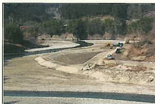
矢作ダム堆積土砂掘削状況
