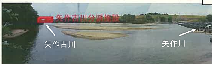
■分派点から矢作川下流を望む
