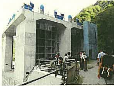
土砂バイパストンネル(呑口)工事状況見学
