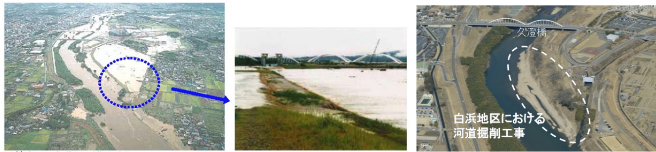
平成 12 年東海豪雨災害時の状況(御立地区付近) 出典:矢作川水系河川整備基本方針
