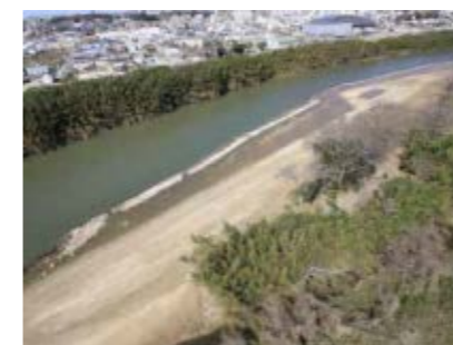
竣工時② 2012/3/20 (豊橋河川事務所)
