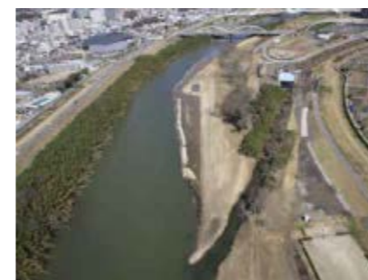
竣工時① 2012/3/20 (豊橋河川事務所)
