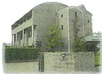
桜井本社ビル
