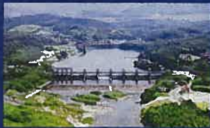
明治用水頭首工
