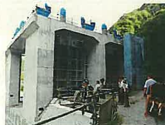
土砂バイパストネル（呑口） 工事状況見学
