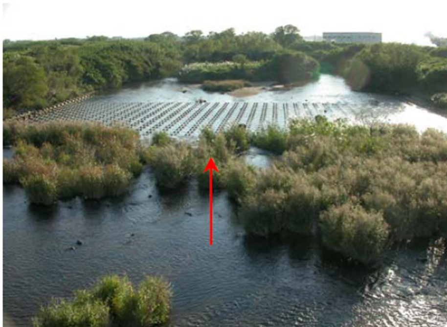
古川頭首工付近 (下流望む)
