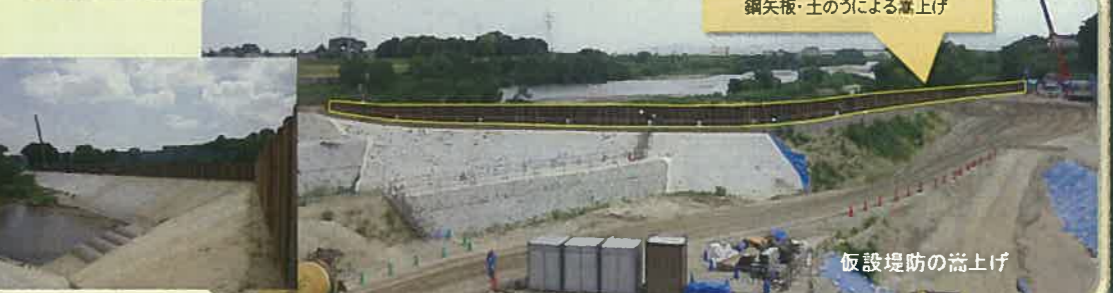
仮締切堤を鋼矢板・土のうで嵩上げ
