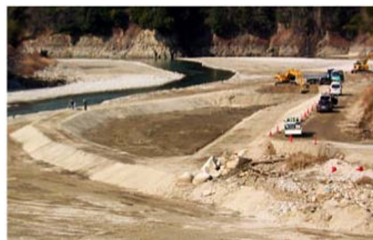
貯砂ダム上流の掘削（大竹地区）
