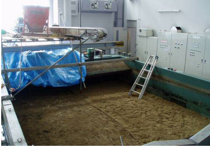
区画内を半分(8m×2.5m)に仕切り、ダム砂を敷設
