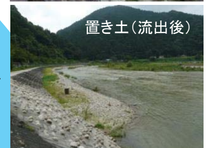
置き土による土砂供給 (矢作川) 14
