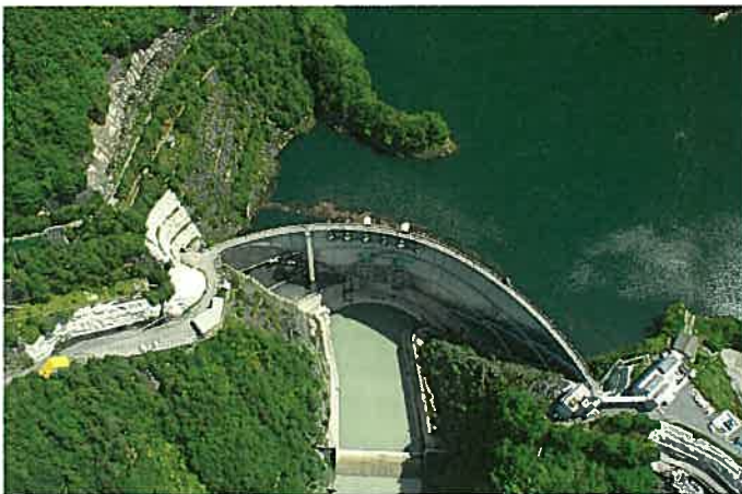
上空から見たダム
