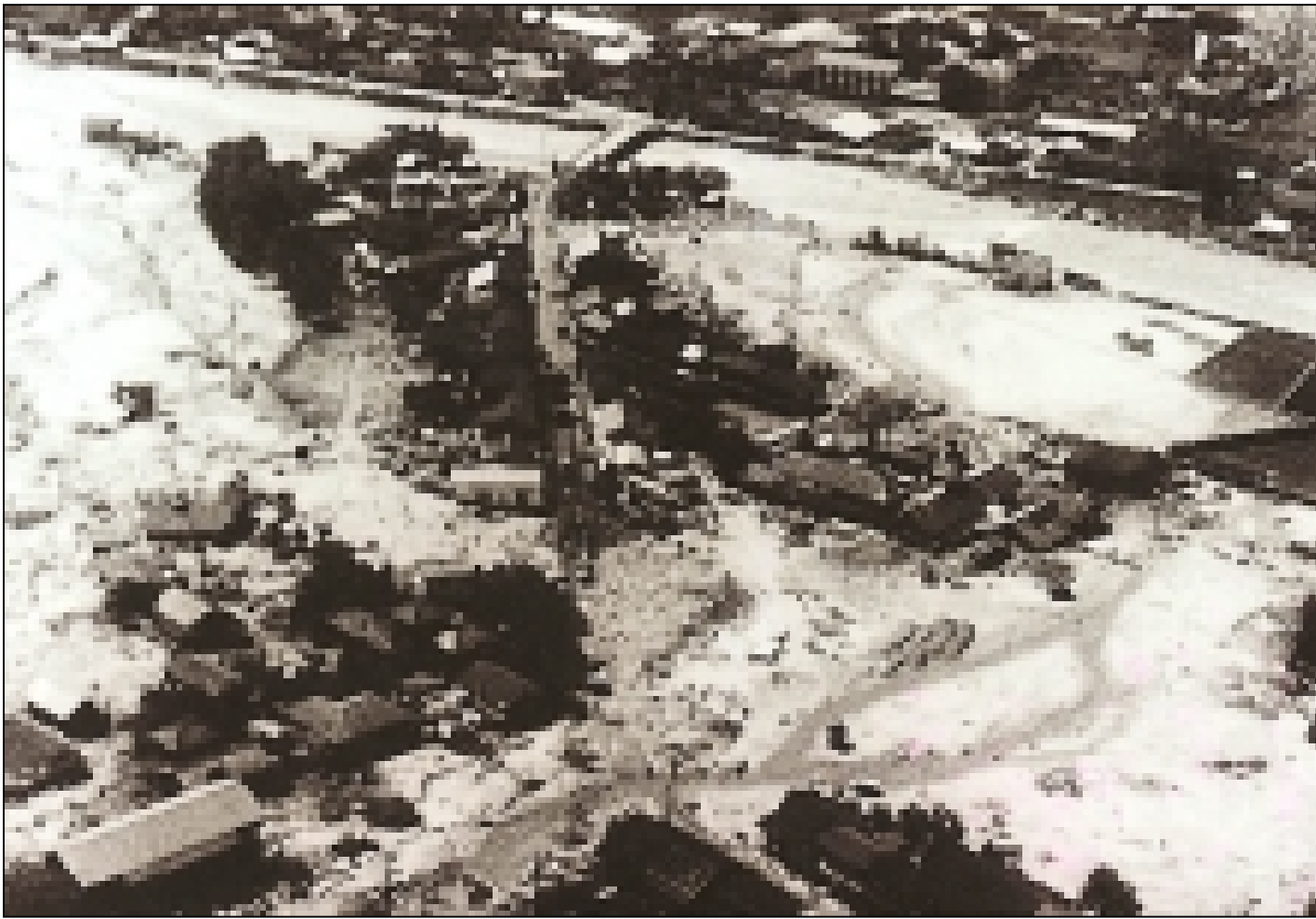
飯田市上郷町野底川下流氾濫状況。上流から望む。
