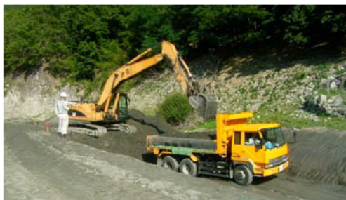
小渋ダム堆砂掘削状況
