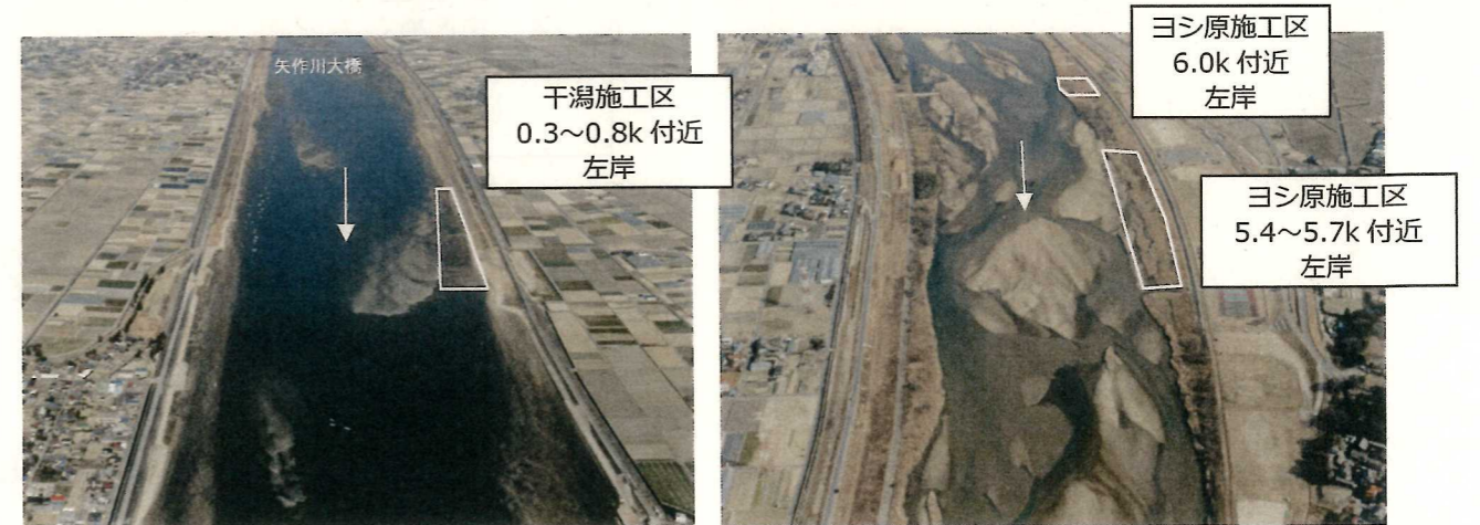
干潟施工区 (左)、ヨシ原施工区 (右) (※H25 年 1~2 月撮影)
