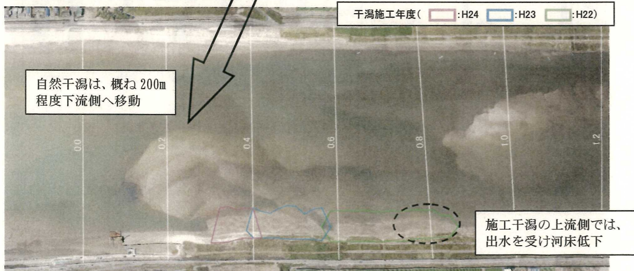
H26.10 撮影 ※干潮時（施工後4年目）
