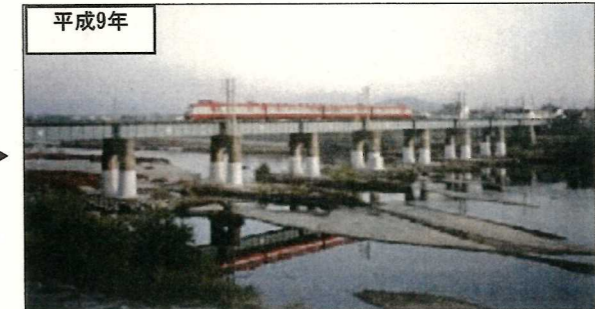
【名鉄西尾線矢作川橋梁の河床低下状況】
