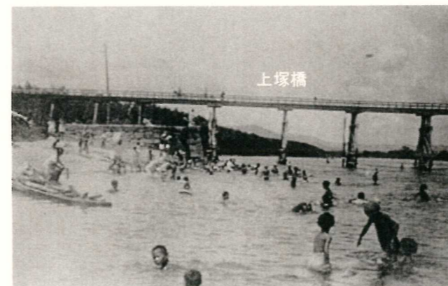
【昔の水浴の状況 (上塚橋: 7k 付近)】
