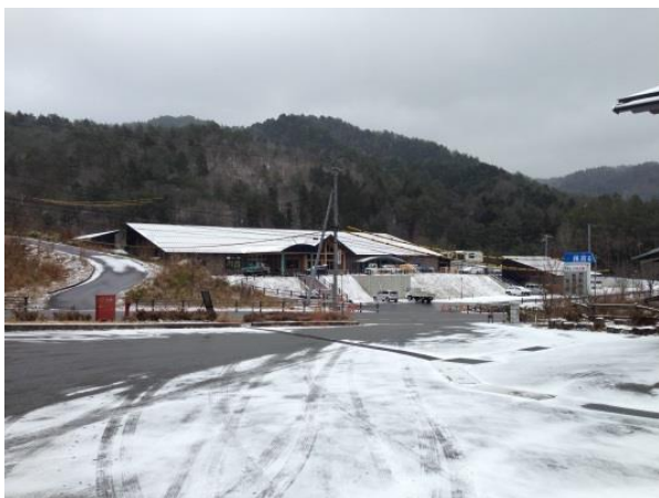
③ 建設中のねばねの里なごみ。ここで間伐材が薪ボイラーの燃料として利用される
