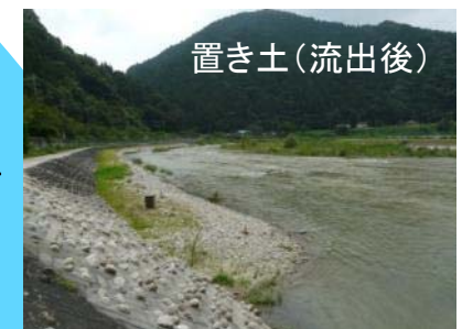
置き土による土砂供給 (矢作川)
