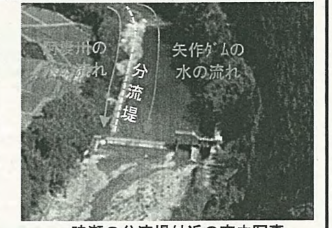
時瀬の分流堤付近の空中写真 (国土交通省, 2013)
