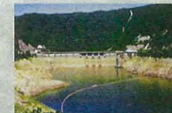
渇水のため水位が下がった矢作ダム (平成8年9月:貯水率17%)
