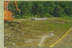
ダム貯水池の流木処理
