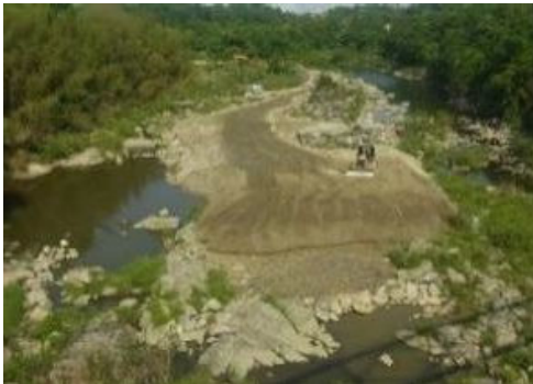
越戸ダム下流の置土実施状況(過年度)
