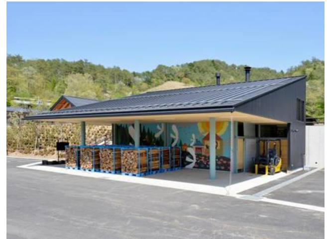
福祉施設のボイラー棟
