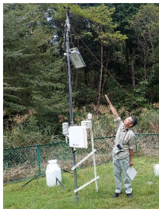
気象観測施設。雨量・気温・湿度・風速・降雨水質等を測定している。
