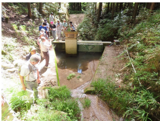
流域の最下流に設置された堰。水位が5分間隔で計測されており、時々刻々の流量データが取得されている。
