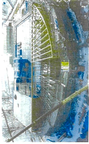
3次元の円弧を描く木組。3DCADによりミリ単位の柱・梁の詳細寸法を割出し、手刻みで実現。
