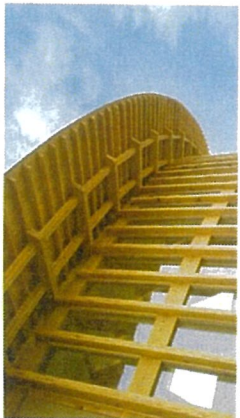
根羽村産の化粧材と大きく異なる新の取合い。出桁に問題を際立たし、その上に垂木を載せる構造。仕口が手刻みで丁寧に加工されているので、材どうしの隙間が美しい隙間となりとなっている
