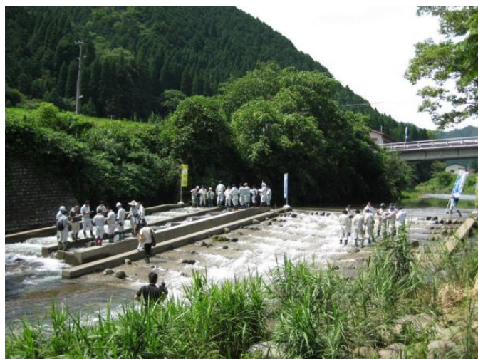
点検状況（魚道下流から上流を望む）
