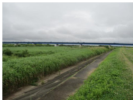
写真2 同左：護岸右は高水敷
