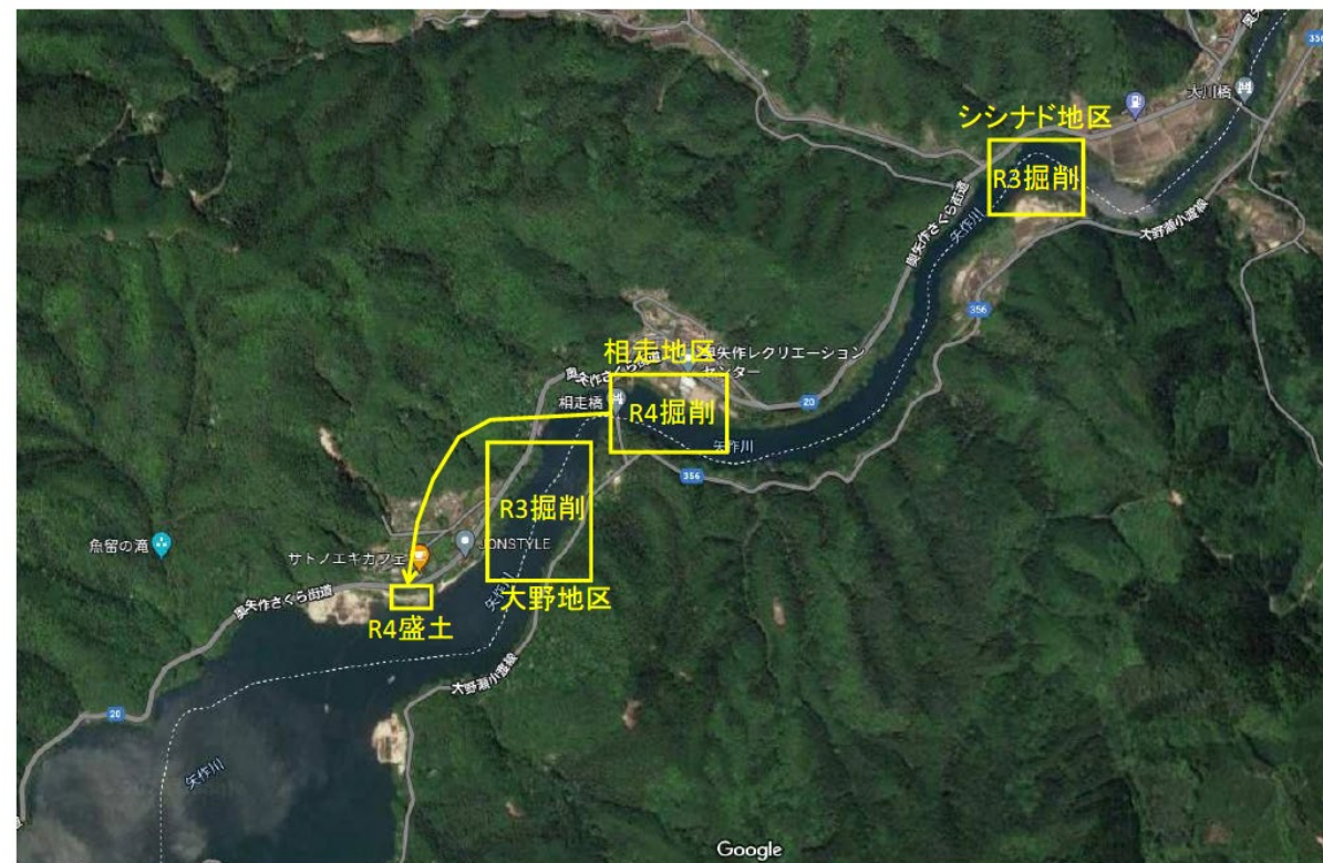
図 2.1 矢作ダム浚渫箇所
