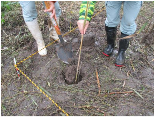
写真9 ヨシ植え作業（表土を鉢状に掘る）
