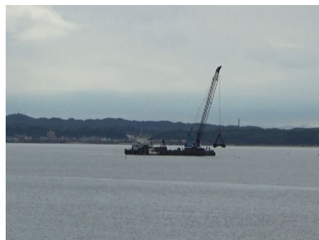
干潟造成の工事の様子
