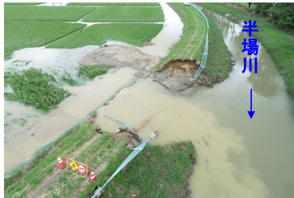
ドローンによる被災状況調査
