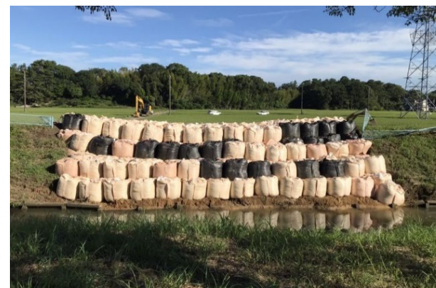
応急仮復旧完了 (7月28日AM7時20分)
