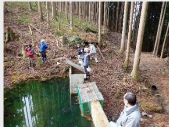
流下する水などを計測するダム
