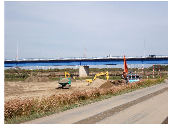
ヨシ原再生により発生した土砂（工事の様子）
