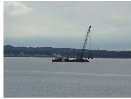
干潟造成の工事の様子
