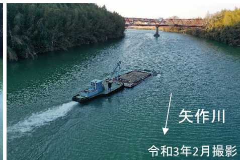
● 浚渫土砂運搬の様子
