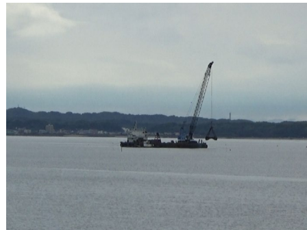
干潟造成の工事の様子
