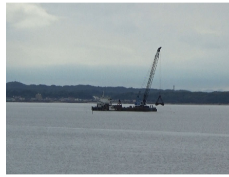
干潟造成の工事の様子
