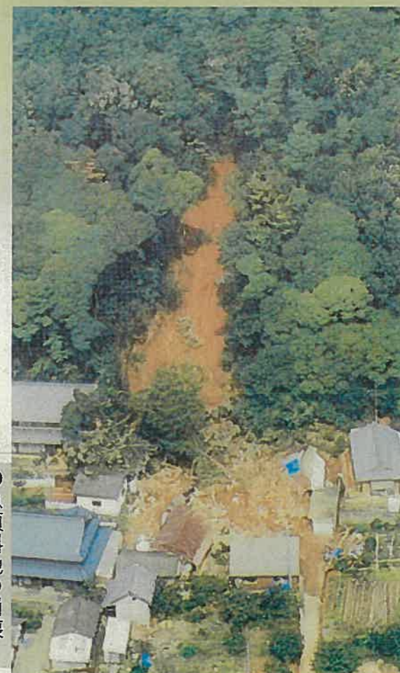
● 急傾斜地の崩壊 (かけ崩れ) 平成12年 大山地区(小牧市)
