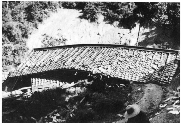
裏山が崩壊して、全壊となった。(中区 松名)
