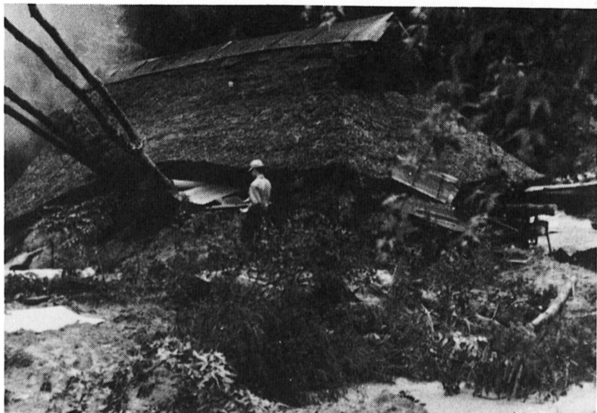
右前山が崩壊して、大木とともに土砂が直撃した。(道慈区 三ツ久保)
