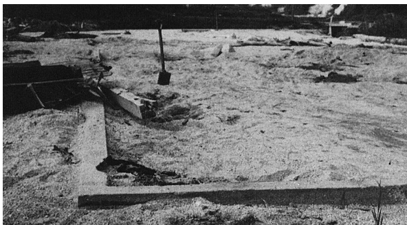
土台を残して全壊流失した大洞公民館
