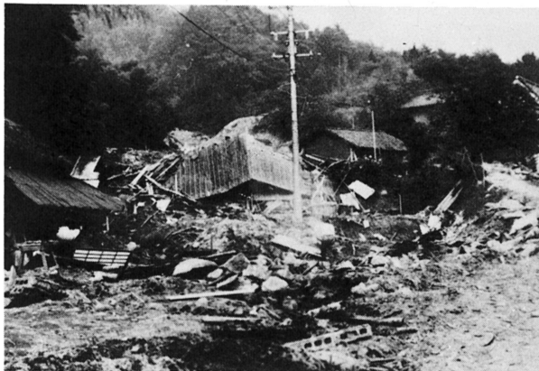
土砂に押しつぶされ、屋敷下へ押し流された。(栄区 下仁木)
