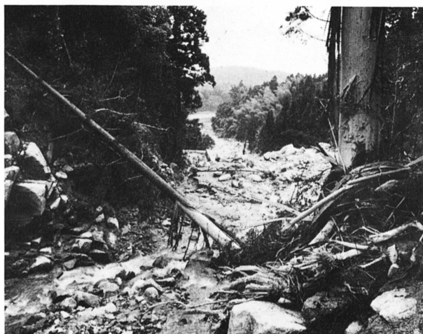
道慈区 大洞 大洞水神池
