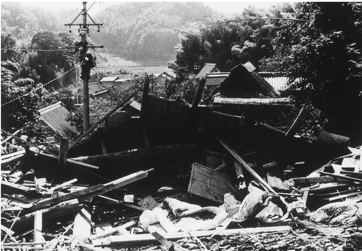
倒壊した家屋（下仁木）
