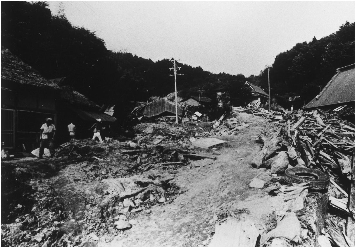
流出した土石と家屋廃材（下仁木）
