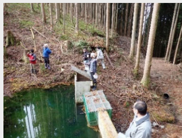
流下する水などを計測するダム
