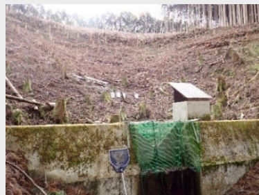
皆伐された斜面と計測施設
