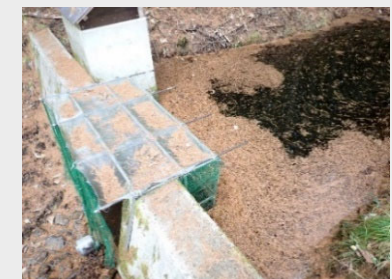
流下する水などを計測するダム
