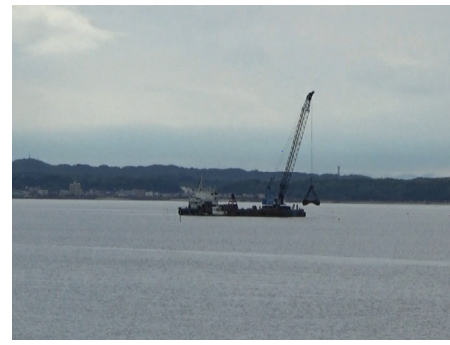
干潟造成の工事の様子
