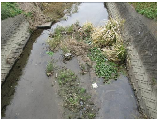
写真 7 No.6 西大排水路の中流
