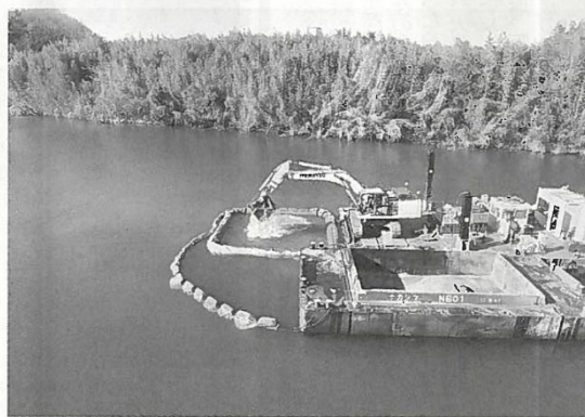
鵜の首では浚渫船に重機を乗せて川底の砂を掘削。昨年度は11月～3月中旬に行われていた
