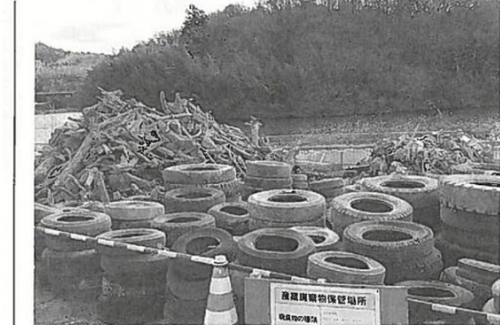
鵜の首の掘削工事では、投棄タイヤ等のゴミも驚くほどたくさん引き上げられた
