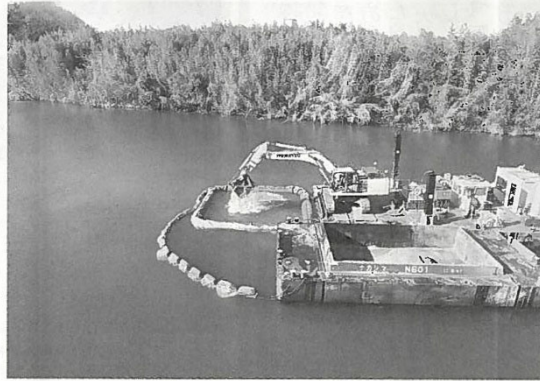
鵜の首では浚渫船に重機を乗せて川底の砂を掘削。昨年度は11月～3月中旬に行われていた
