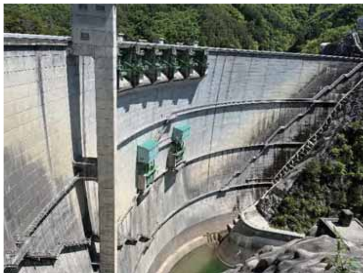
小渋ダムと排砂バイパストンネル
