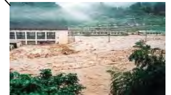
河積不足による外水氾濫で幼稚園が流失、小学校も被災し、地域社会へ与えた被害は甚大（愛知県旧旭町）
