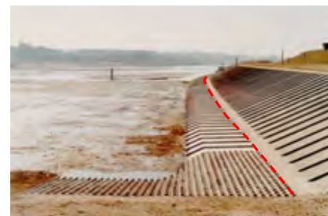
【低水護岸整備による堤防強化】
