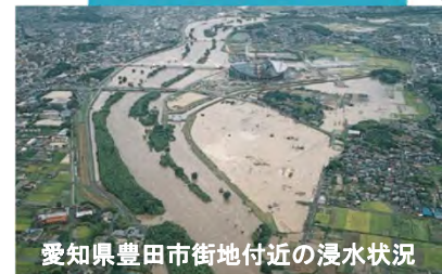
愛知県豊田市街地付近の浸水状況 堤防整備が進んでいない地区では、越水による浸水被害が発生
