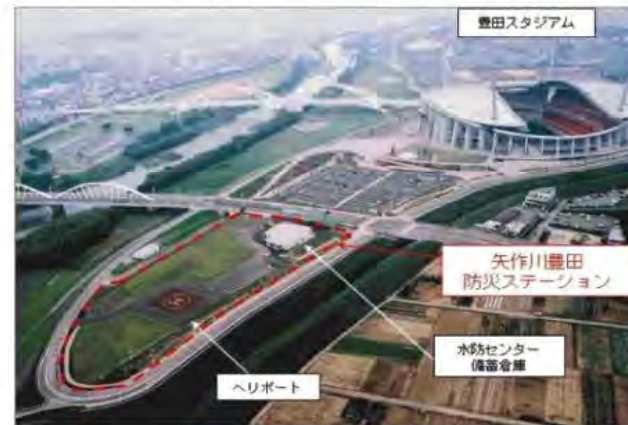
河川防災ステーション
