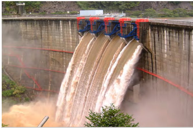
洪水調節中の矢作ダム
