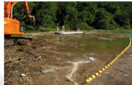
ダム貯水池の流木処理
