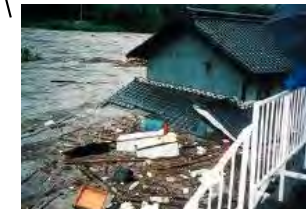
河積不足による外水氾濫で床上浸水が発生（愛知県豊田市）
