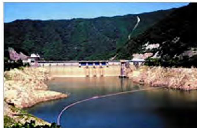
渇水のため水位が下がった矢作ダム（平成6年9月：貯水率17%）
