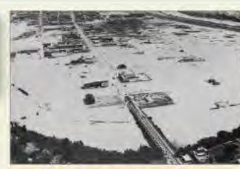
S47洪水/豊田市の浸水状況
