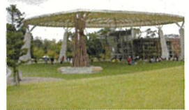
大屋根の広場
