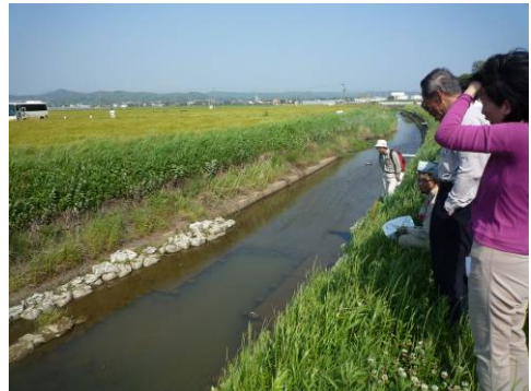
水路マス設置箇所
