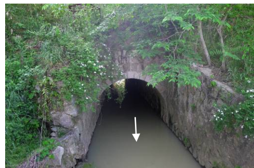
橋梁奥のトンネル（明治用水下を貫流）
