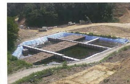
②仮設沈砂池設置による工事中の排水対策
