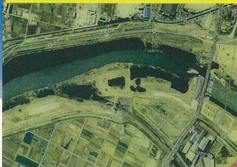
久済橋付近状況(平成4年1月撮影)
