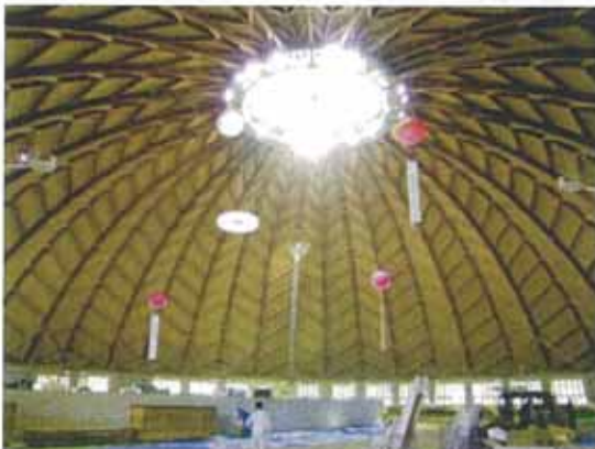
写真-6 やまびこドームの外観と内部
