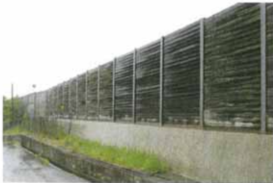
写真-10 設置後 27 年目のカラマツ製遮音壁
