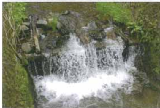
写真-9 丸太法枠工、木製修景工、木工沈床
