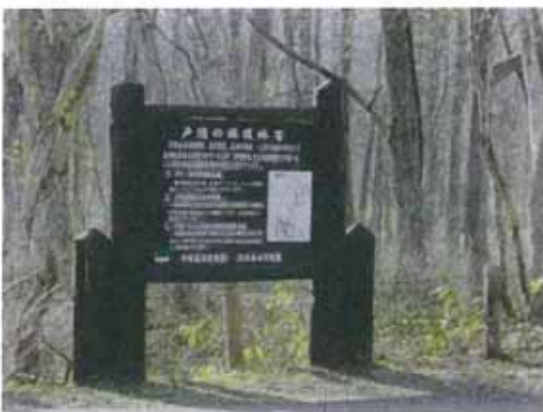
写真-5 バリアフリー歩道（木道）、木道橋、丸太階段工、木製案内板
