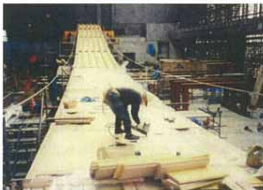
写真-2 ハイブリッド吊り材のサンプルと 建設時におけるハイブリッド吊り材の地組
