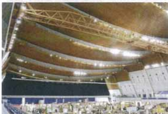
写真-1 エムウェーブの外観と内部
