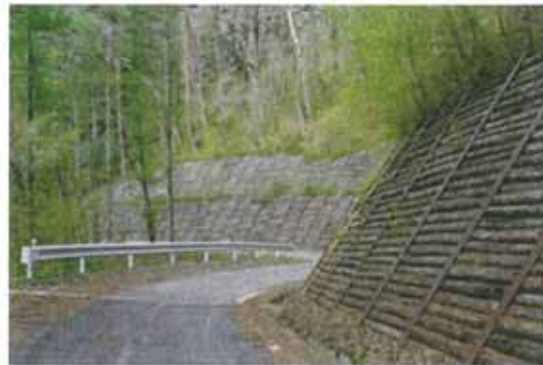
写真-11 木製法面保護工
