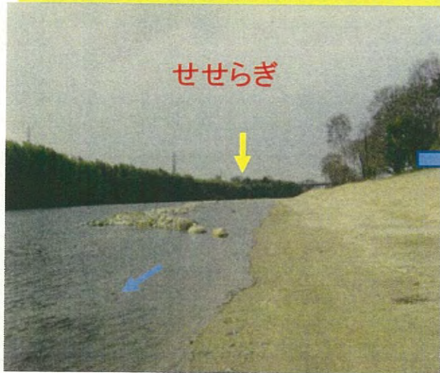
下流部の完成当時の状況
