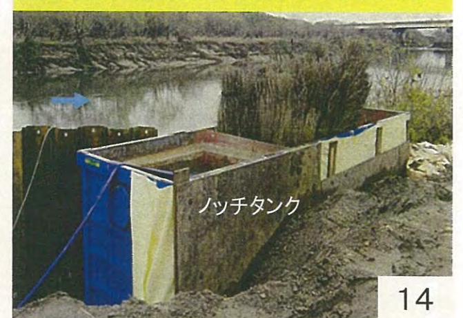
工事中の濁水防止対策(ノッチタンク)
